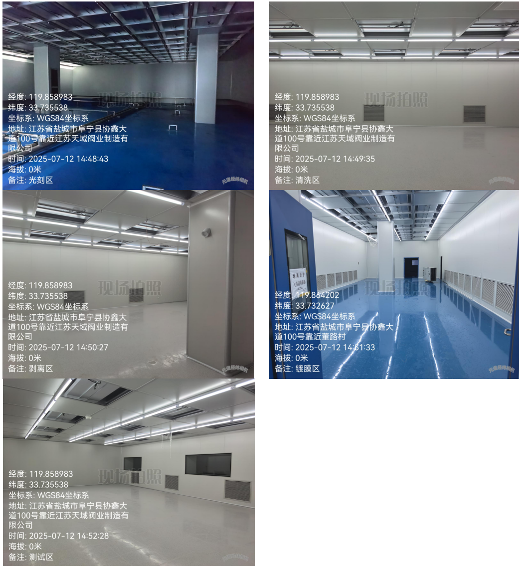
图 2-10 厂房现状照片
