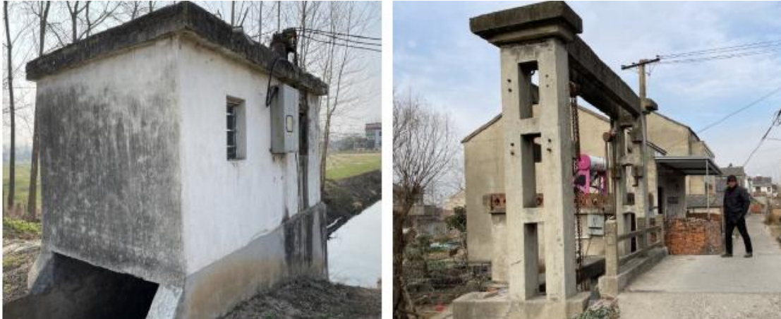
沿线建筑物现状
