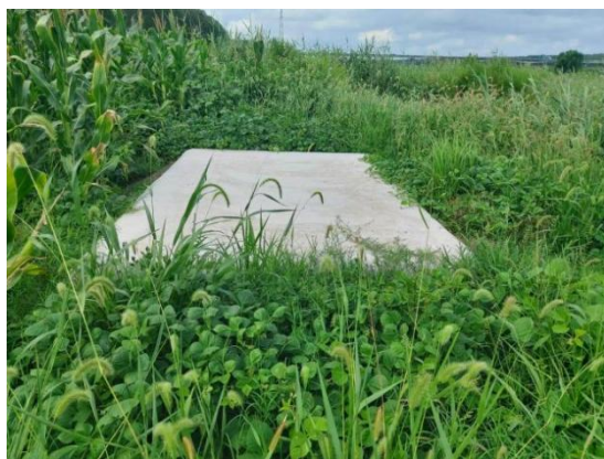
入河前混合池
